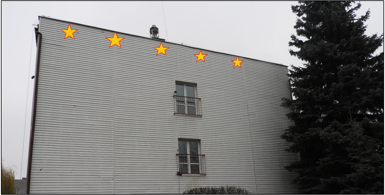
Fot. 12. Proponowane lokalizacje skrzynek dla nietoperzy na elewacji zachodniej budynku.
