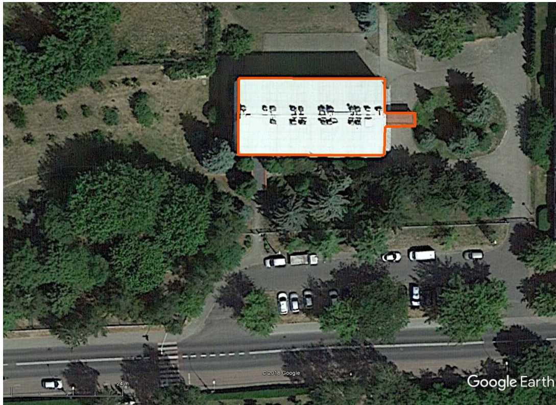
Ryc. 1. Zarys budynku Centralnego Laboratorium Głównego Inspektoratu Ochrony Roślin i Nasiennictwa w Toruniu (czerwona linia) przy ul. Żwirki i Wigury 73 w Toruniu (podkład mapy Google Earth z dnia 09.06.2018).
