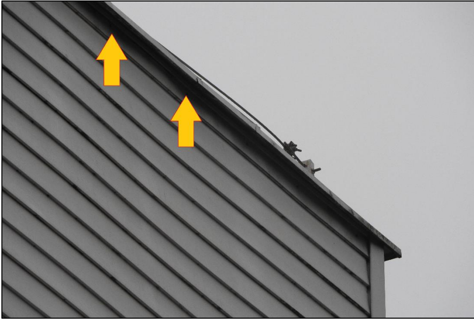
Fot. 9. Zlokalizowane potencjalne wloty na elewacji zachodniej (tu traktowane jako 1 lokalizacja).
