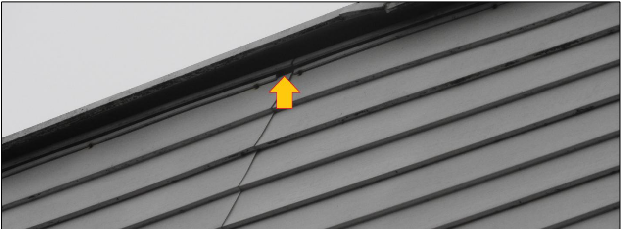
Fot.6. Zbliżenie jednego z zidentyfikowanych wlotów na elewacji wschodniej.
