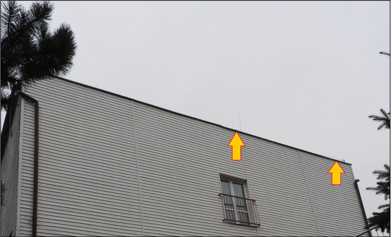
Fot. 5. Potencjalne wloty nietoperzy zidentyfikowane na elewacji wschodniej.
