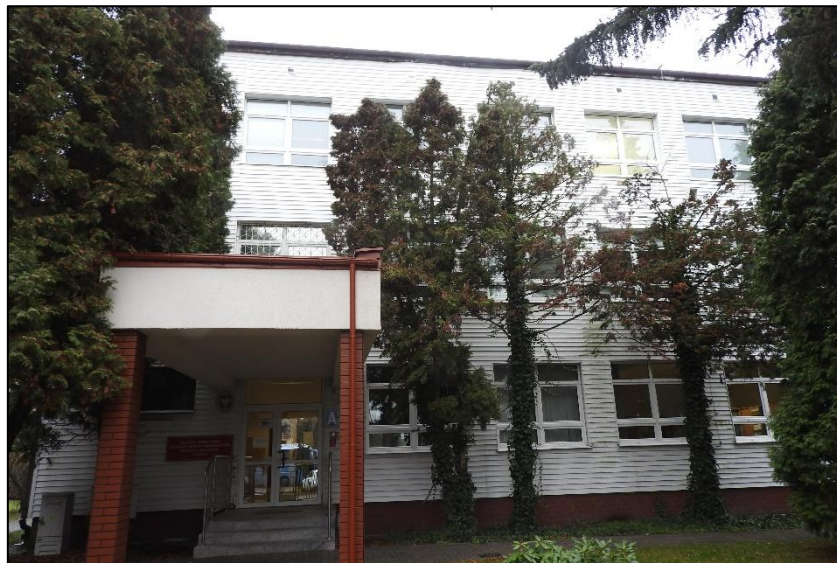
Fot. 2. Widok elewacji południowej budynku.
