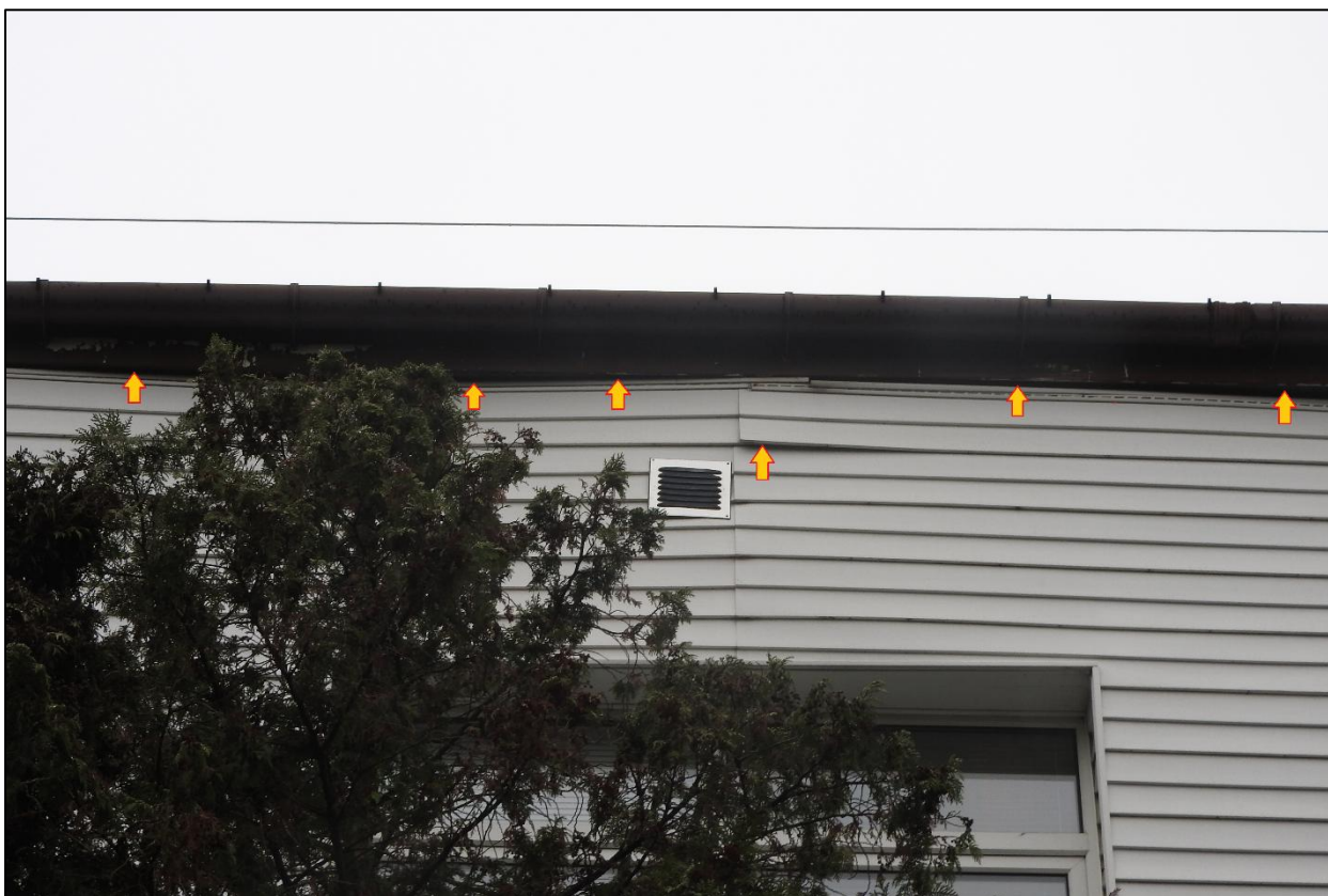
Fot. 8. Zlokalizowane potencjalne wloty elewacja południowa cd.
