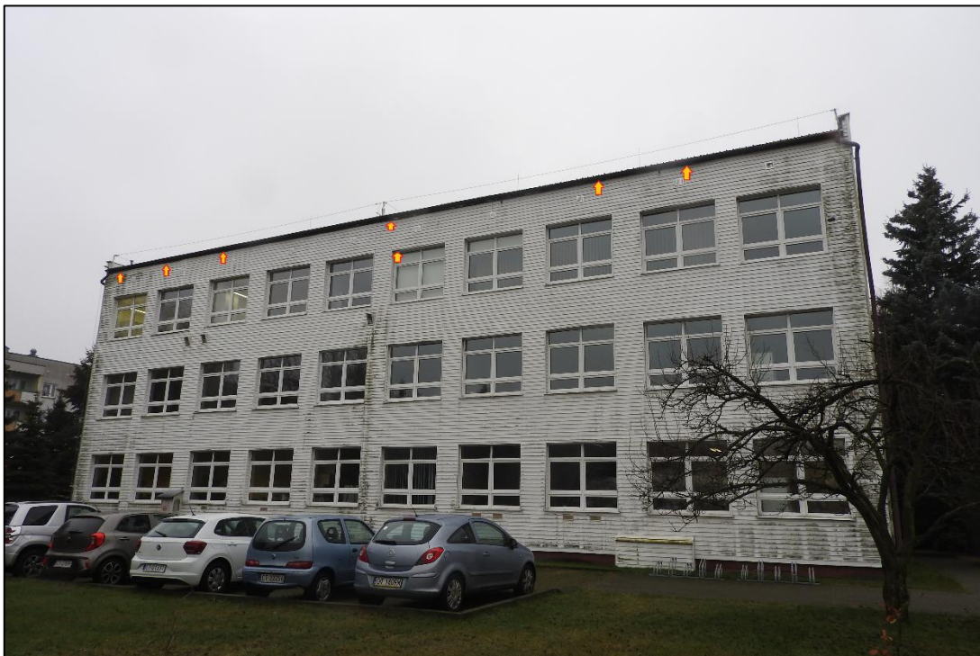
Fot. 10. Zlokalizowane potencjalne wloty na elewacji północnej.
