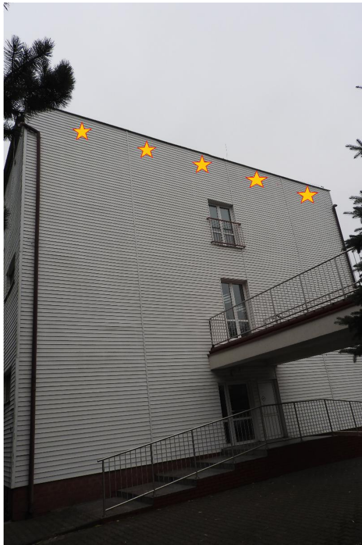
Fot. 11. Proponowane lokalizacje skrzynek dla nietoperzy na elewacji wschodniej budynku.
