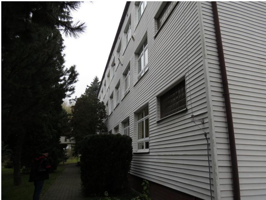
Fot. 2. Ściana południowa badanego budynku.
