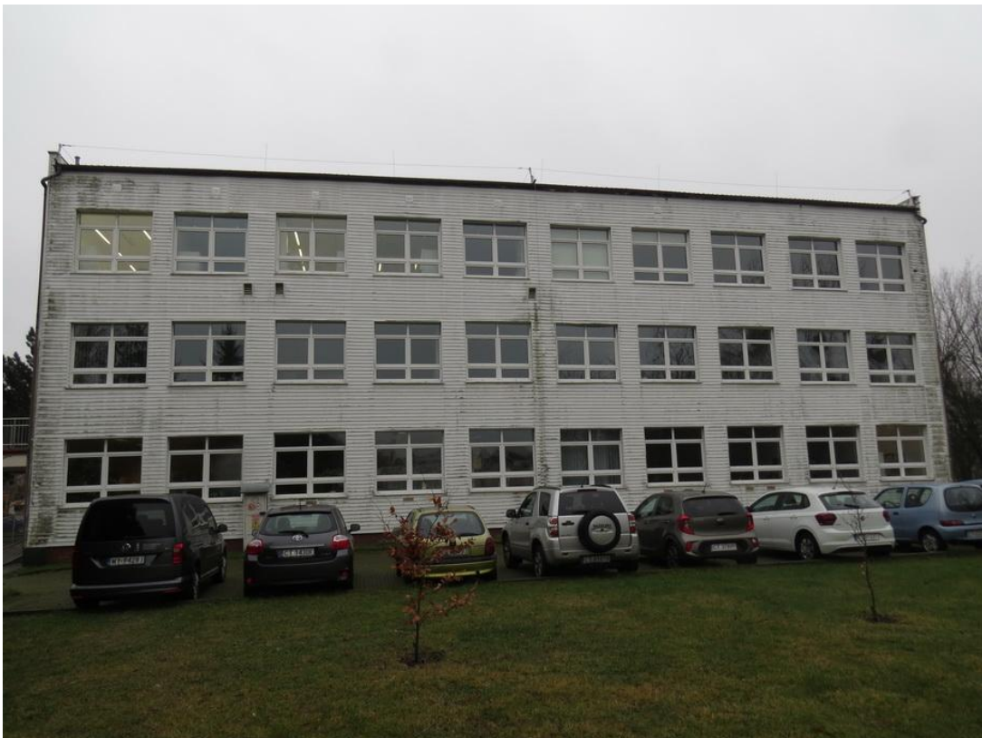
Fot. 4. Ściana północna budynku Centralnego Laboratorium.
