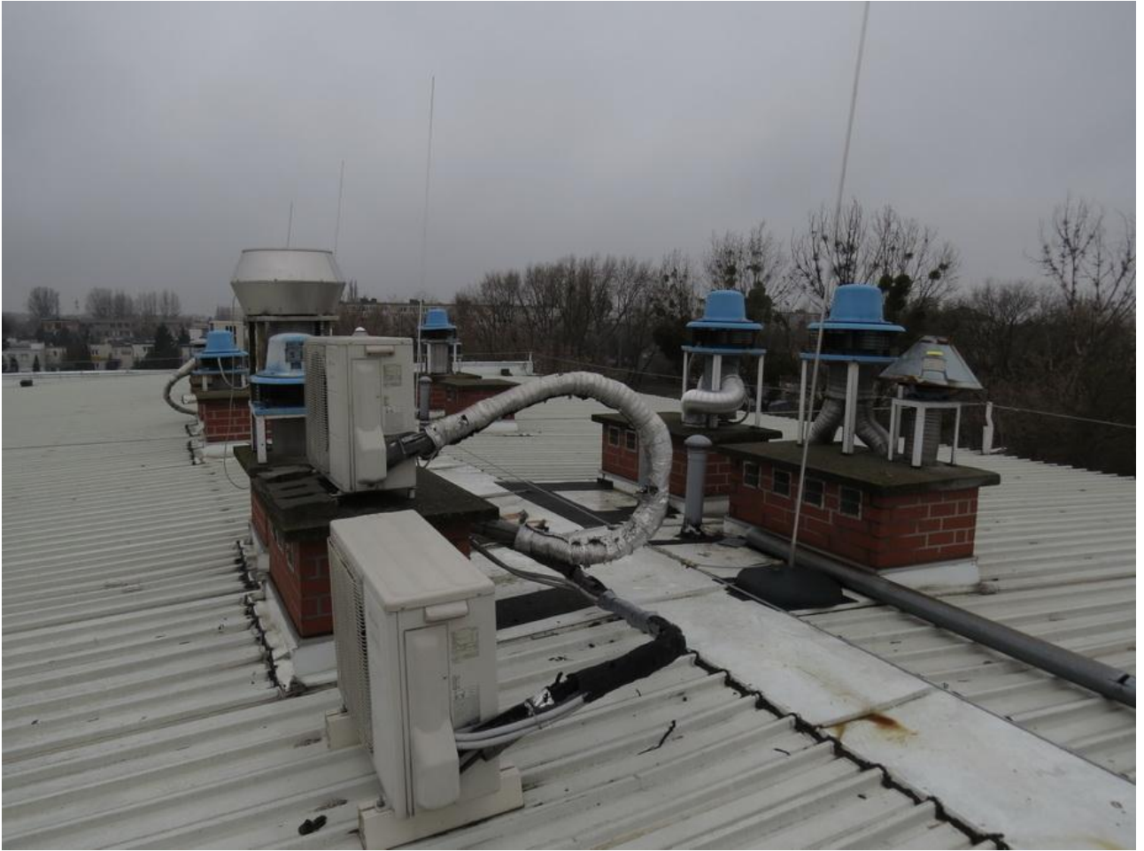
Fot. 5. Dach budynku Centralnego Laboratorium Głównego Inspektoratu Ochrony Roślin i Nasiennictwa w Toruniu przy ul. Żwirki i Wigury 73 w Toruniu.
