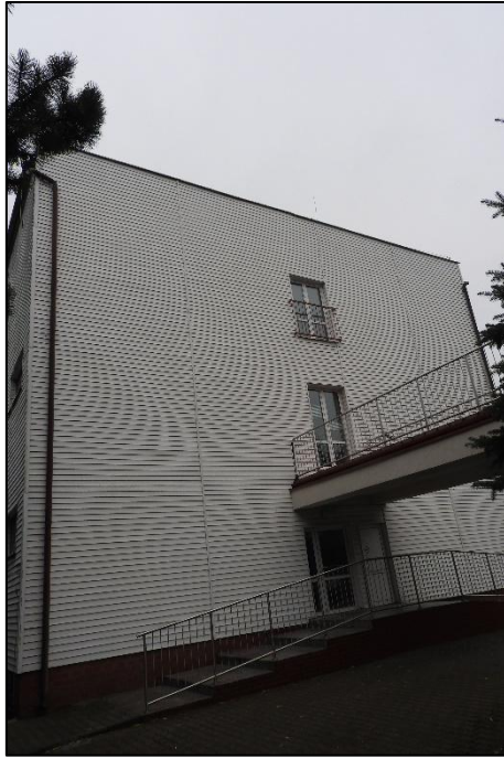
Fot.1. Widok na elewację wschodnią budynku.
