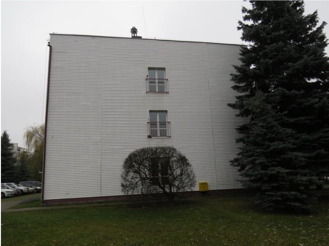
Fot. 3. Ściana zachodnia budynku Centralnego Laboratorium.
