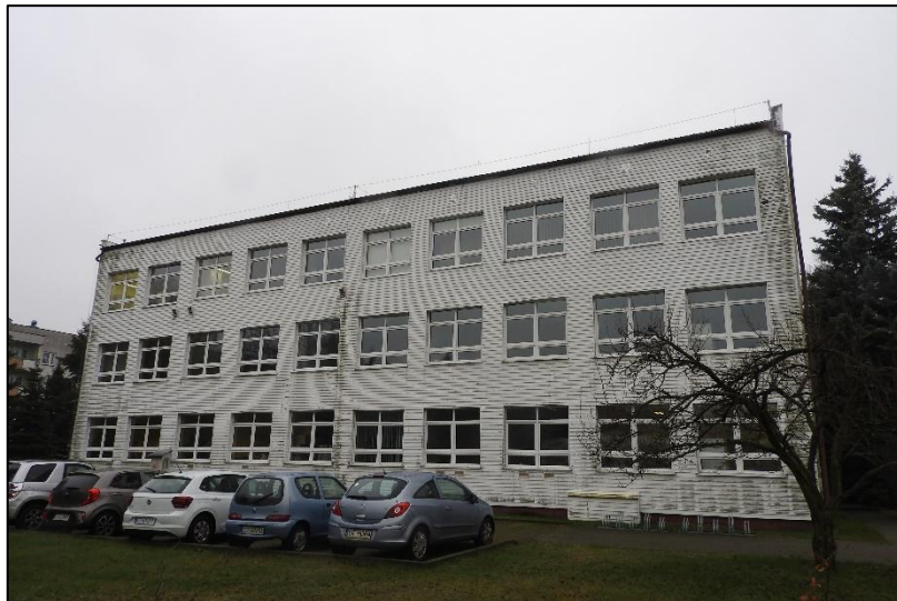
Fot. 4. Widok elewacji północnej budynku.
